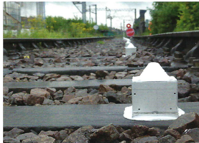
Bild 12: Gleisüberwachung mittels drahtloser Neigungssensoren
